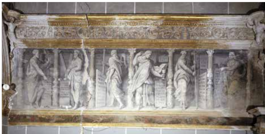
6 y 7 (página derecha). Decoración de los muros oeste y norte de la capilla de la Purificación antes de la restauración.
