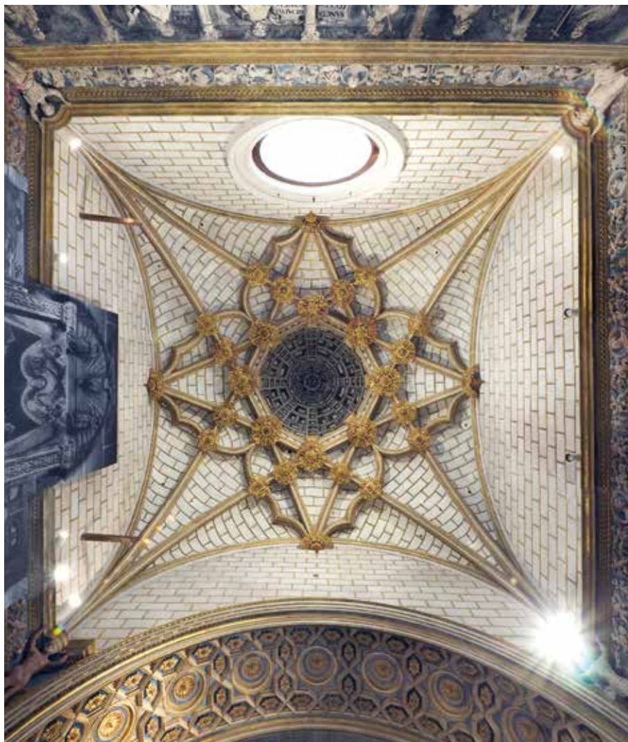
18. Bóveda de la capilla de la Purificación después de la restauración.
