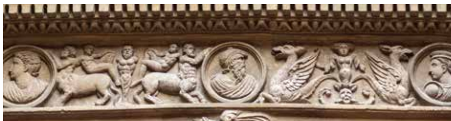
45. Detalle de uno de los frisos desplegados sobre la columnata de la planta baja del Patio de la Infanta de Zaragoza.
