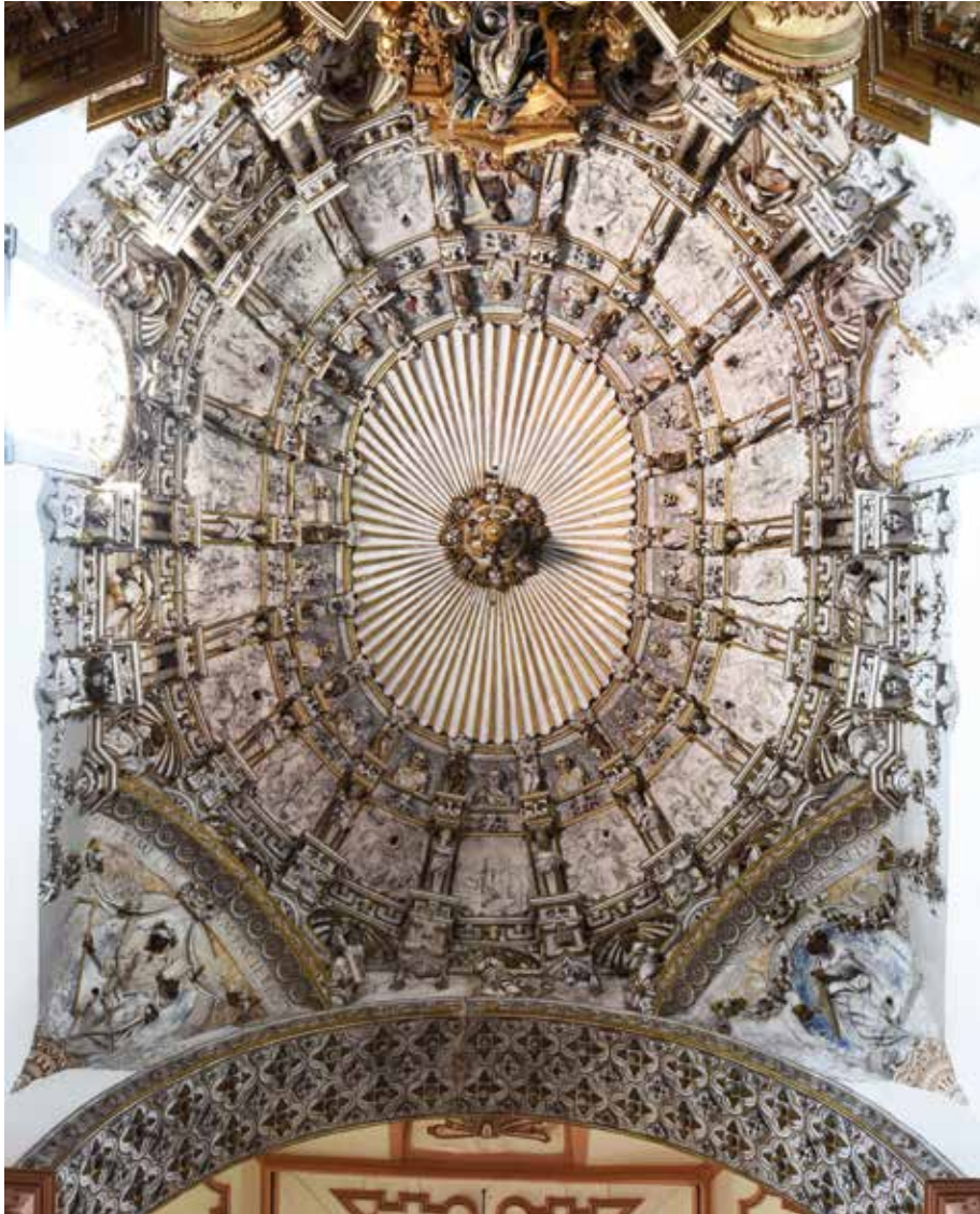
12. Cúpula de la capilla mayor. Parroquia de San Juan Bautista de Rodilana.
