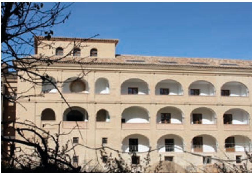
Fig. 23. Exterior del monasterio nuevo de Santa María de Veruela. Foto Rebeca Carretero.
