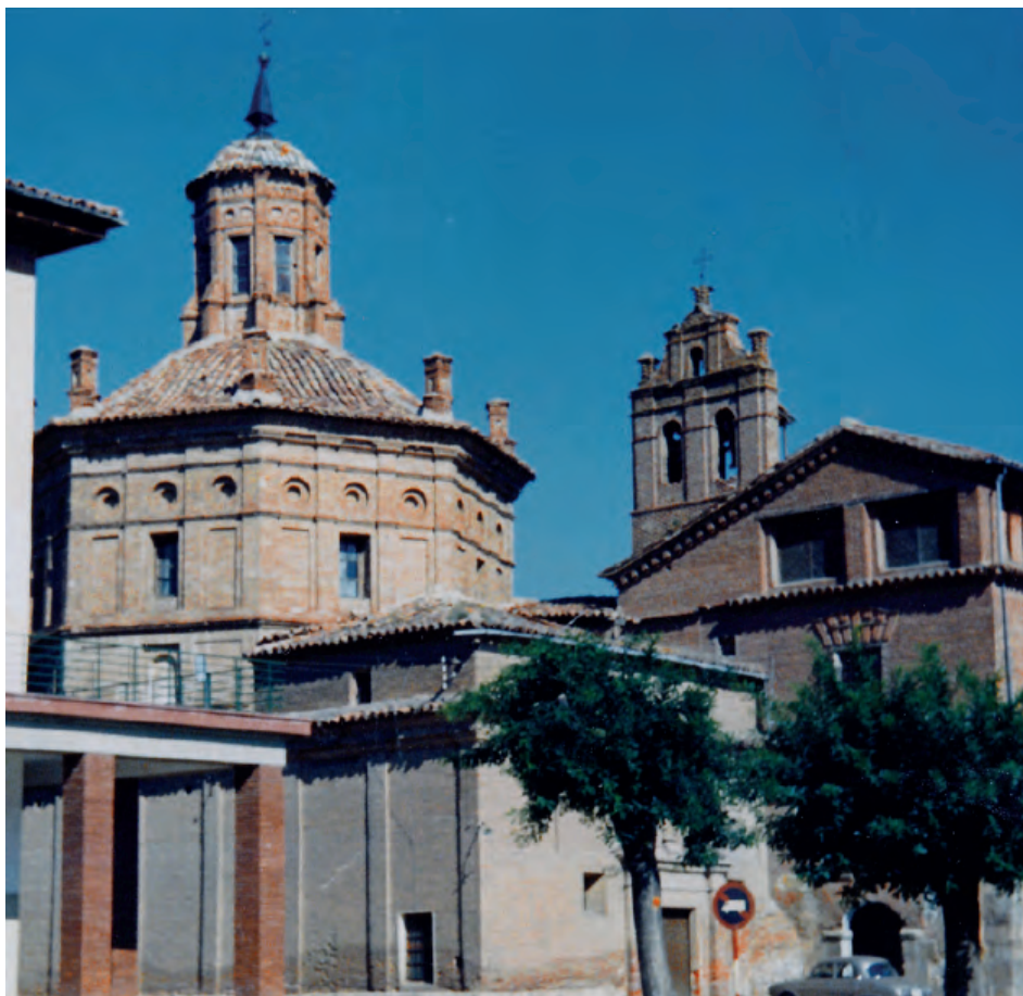
Fig. 7. Exterior de la iglesia y oficinas del convento. Calatayud, convento de San José. Gaspar de Villaverde y Francisco de Aguirre, 1616-1633. Foto Rafael Martín Escartín, cortesía del C.E.B.
