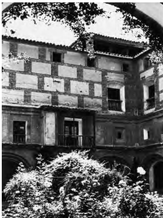
Figs. 10 y 11. Panda norte del claustro con la cúpula de la iglesia (arriba). Confluencia de dos de las pandas (abajo). Calatayud, convento de San José. Gaspar de Villaverde y Francisco de Aguirre, 1616-1633. Fotos cortesía de las Madres Dominicas.
