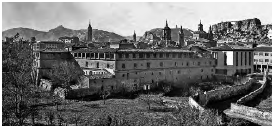
Figs. 12 y 13. Exterior de la galería occidental (arriba). Panorámica de las oficinas conventuales desde el sureste (abajo). Calatayud, convento de San José. Gaspar de Villaverde y Francisco de Aguirre, 1616-1633. Fotos Carlos Moncín.
