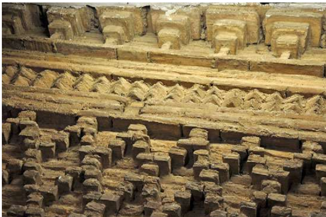
7. Ablitas. Iglesia parroquial de Santa María Magdalena, a) exterior de la nave en el lateral de la epístola y b) detalle del mismo. Juan Guarrás el Viejo (atribuido), hacia 1540-1544. Foto Carlos Becerril.
