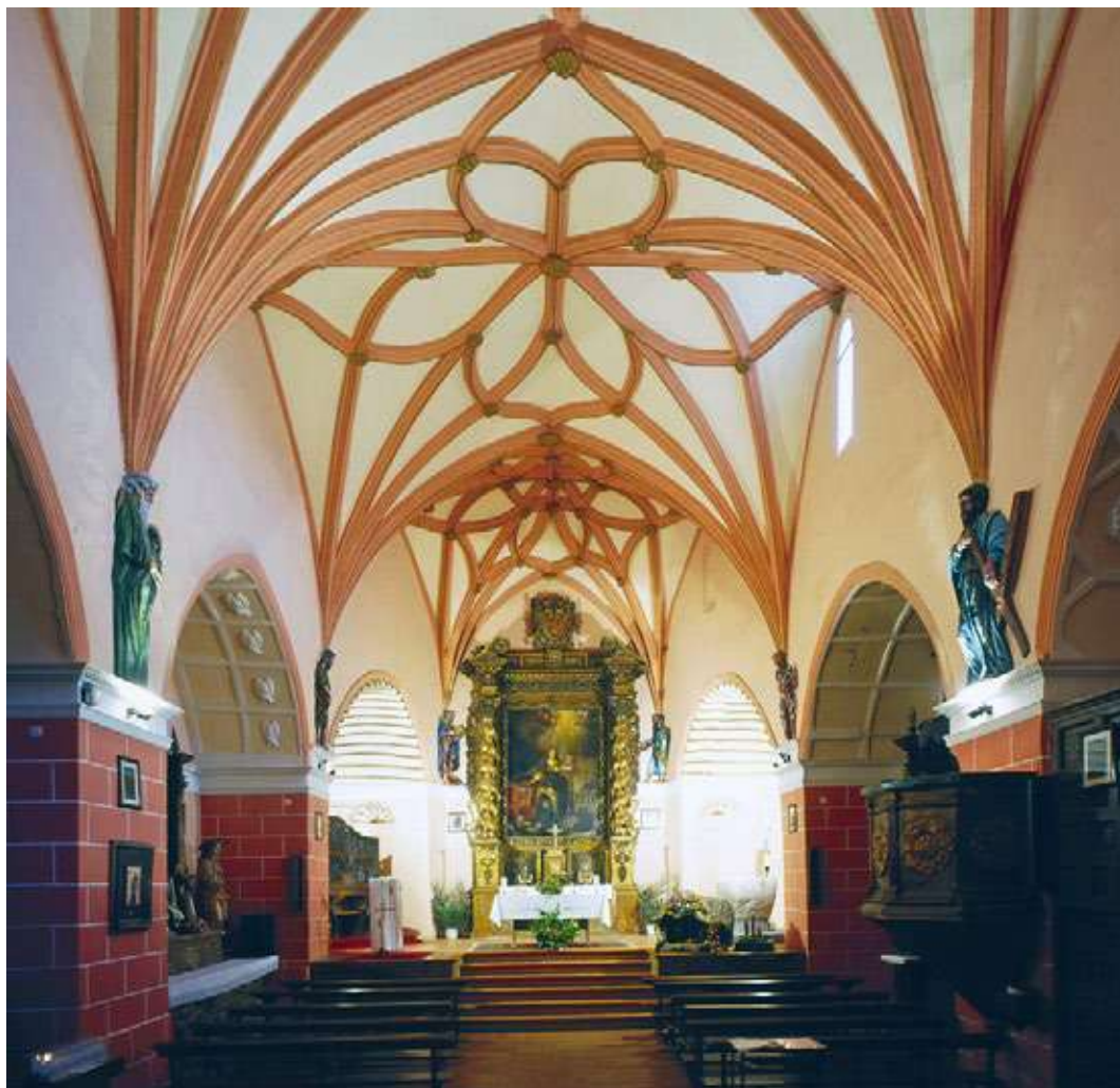
11. Los Fayos. Iglesia parroquial de Santa María Magdalena. Bocelado de la bóveda y ménsulas figurativas. Francisco Guarrás y Bernal del Fuego, 1757. Foto José Latova.
