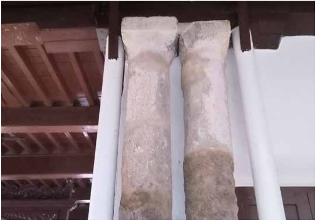
Fig. 2. Columnas del claustro.
