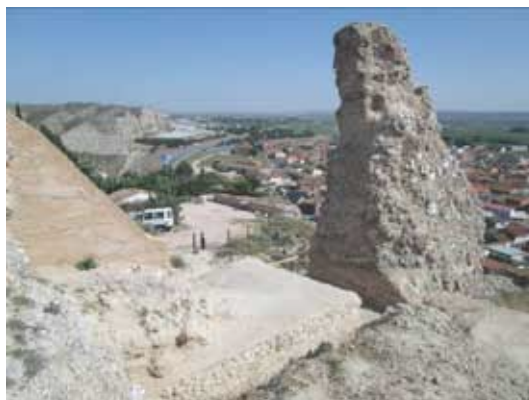
Sancamiento de la coronación acabado.
