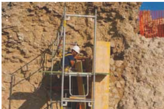
Compleción del muro sur y trabado de la fábrica.
