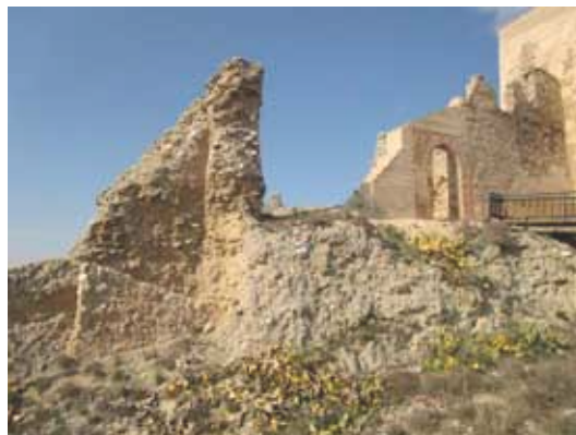
Zona de la actuación después de los trabajos.
