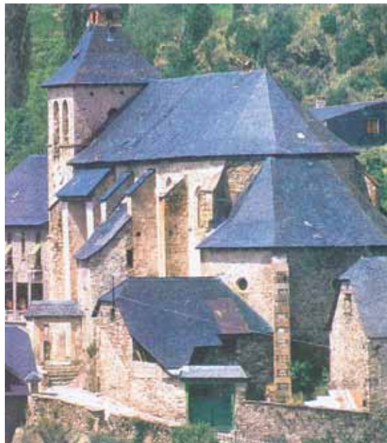
Foto 4. Exterior desde el S.E.
