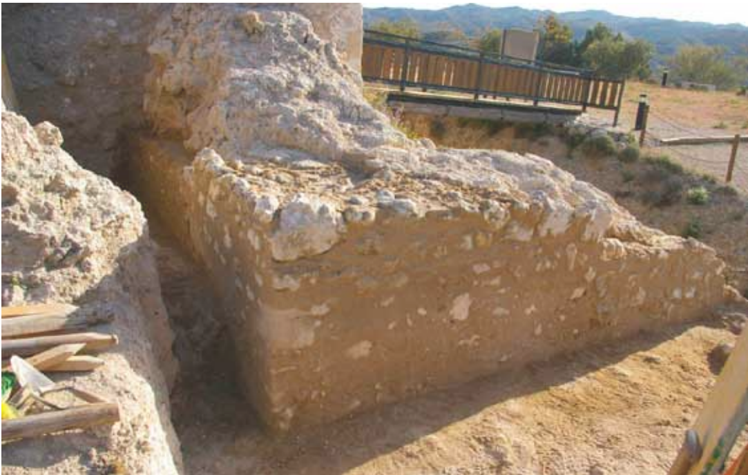
Consolidación del muro norte del interior del torreón.
