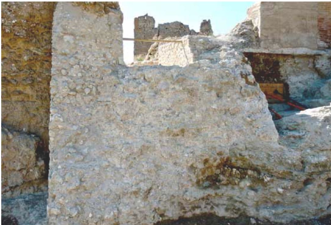
Vista del torreón desde el foso acabando los trabajos.
