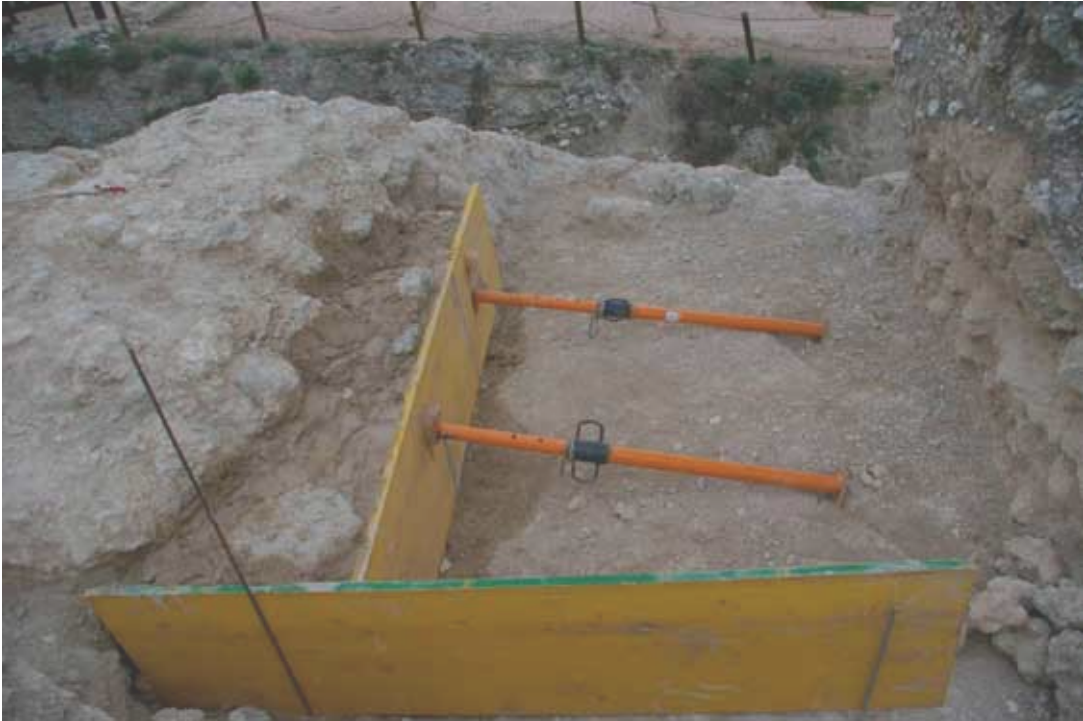
Interior del torreón durante los trabajos de consolidación del muro norte.
