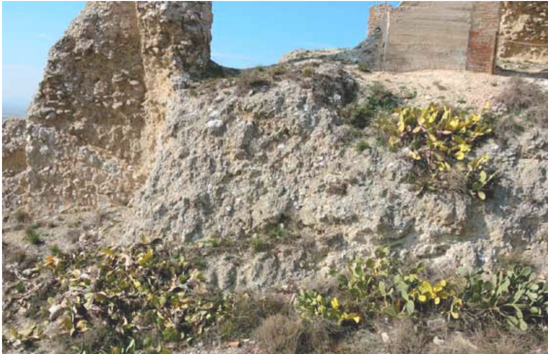
Vista del torreón desde el foso antes de los trabajos.
