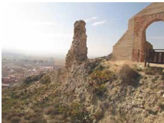
Zona entre el torreón y el acceso antes de los trabajos.
