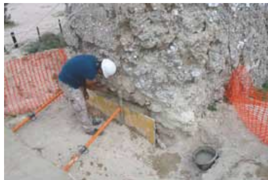
Consolidación de la sección del muro del torreón.
