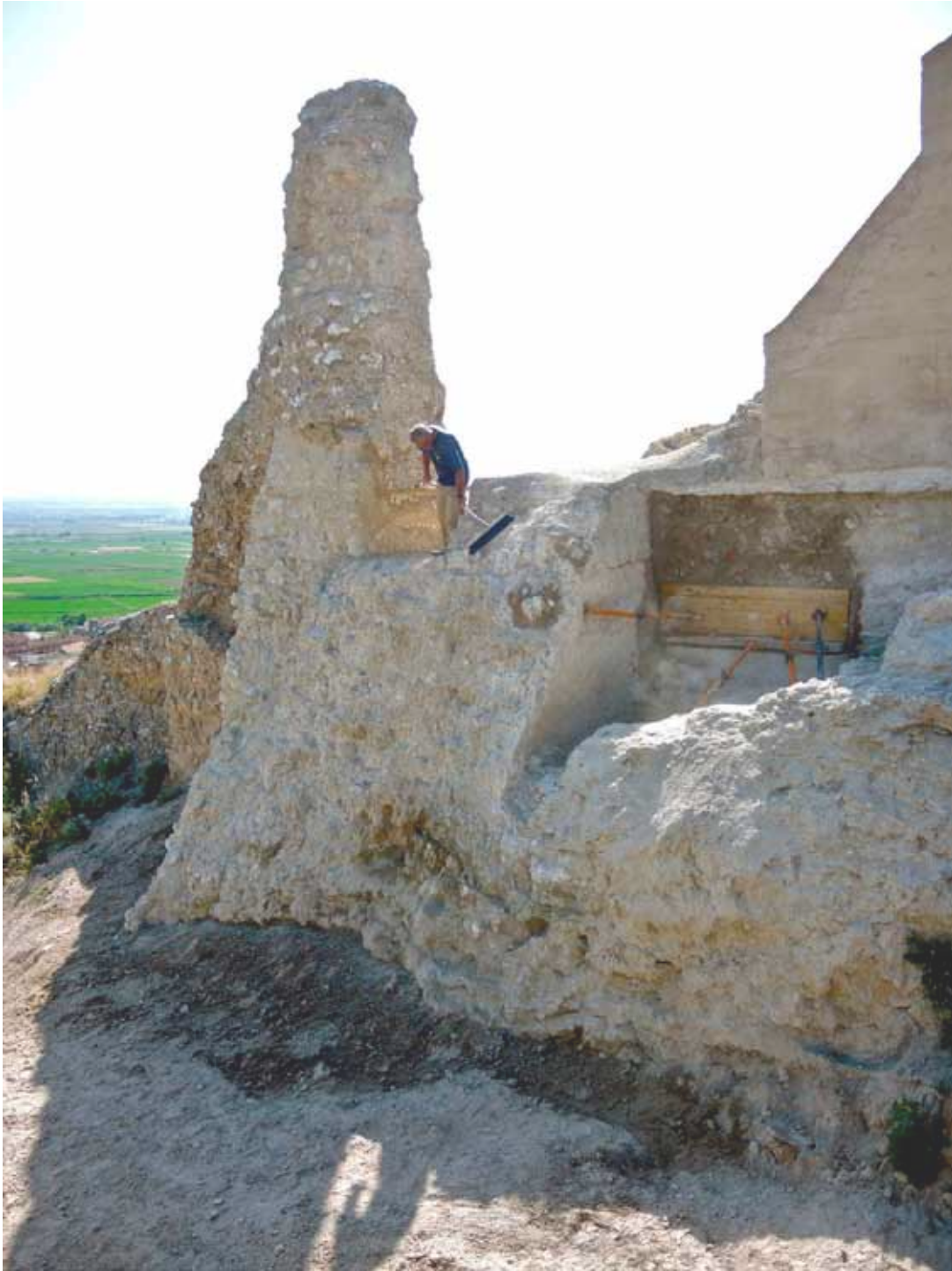
Vista del torreón acabando los trabajos.
