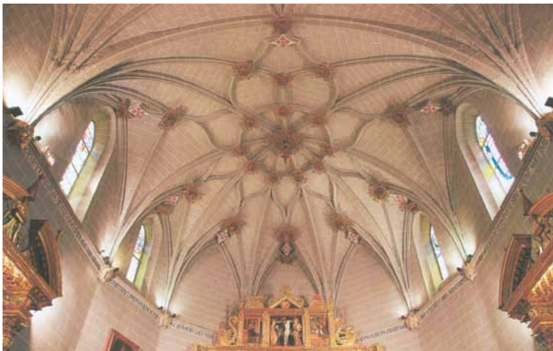
Foto 2. Bóveda de la cabecera de la iglesia.
