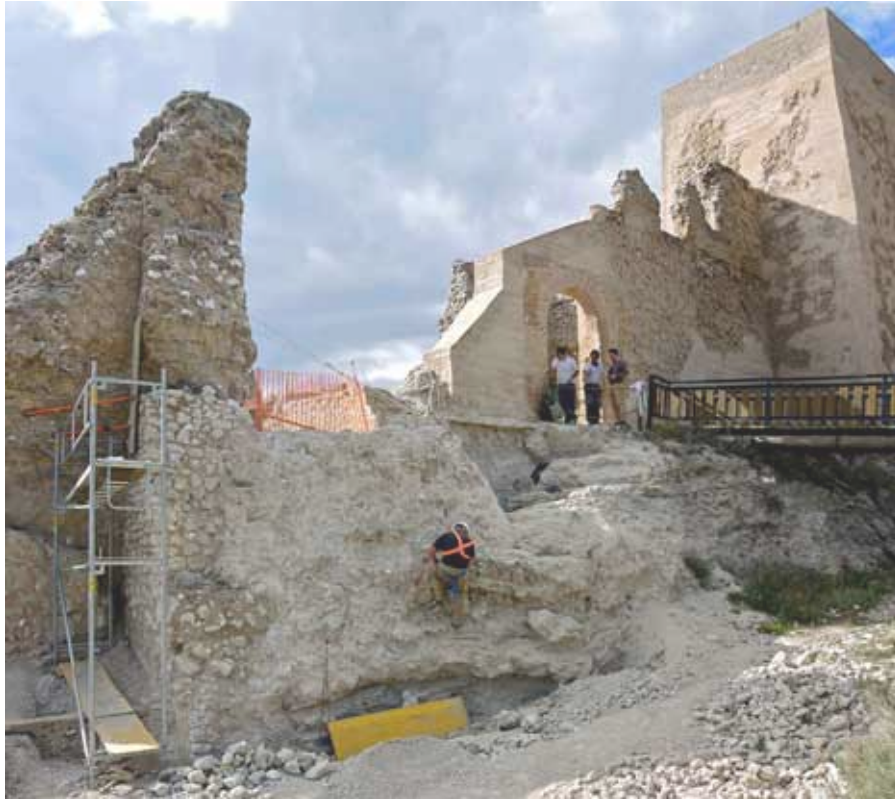
Conjunto de los trabajos: Compleción del muro sur, excavación en el foso, limpieza del frente este y excavación de la zona entre el torreón y el acceso.
