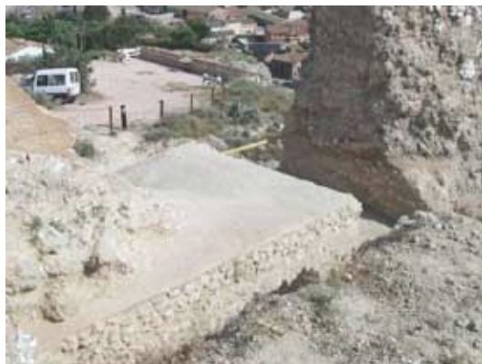
Muros perimetrales e interior del torreón consolidados.
