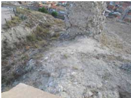
Interior del torreón antes de los trabajos.
